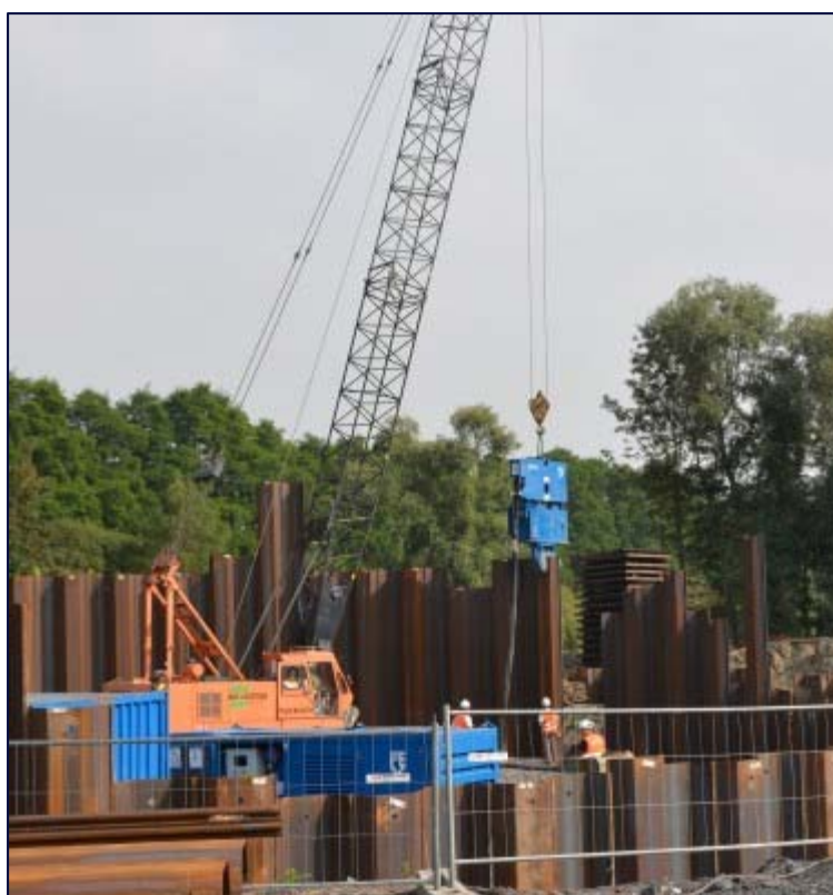
Figure 4 : Moyen de mise en œuvre des palplanches : A gauche par vibrofonçeur et à droite par vérinage
