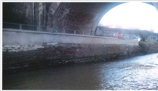
Culée C0 rive gauche Photo : 2
