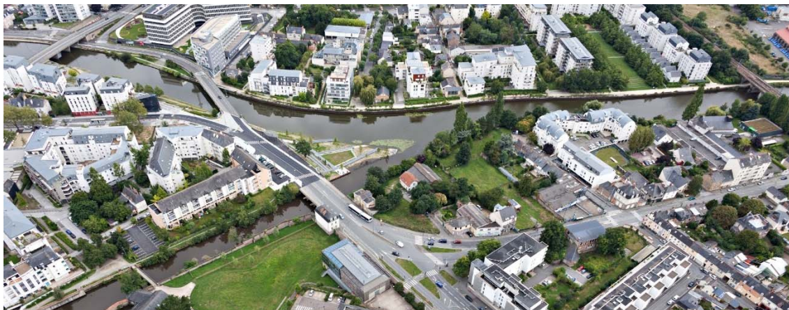
Figure 3 : Vue d'ensemble de la digue d'Aichel
