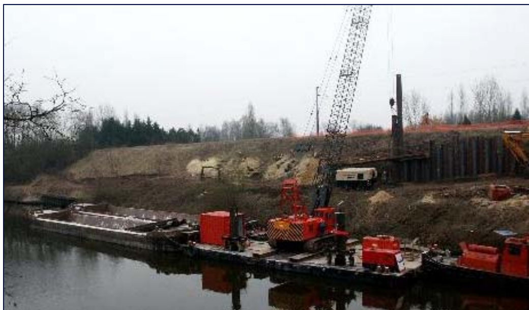
Figure 3 : Exemple d'atelier avec barge, grue sur ponton et remorqueur
